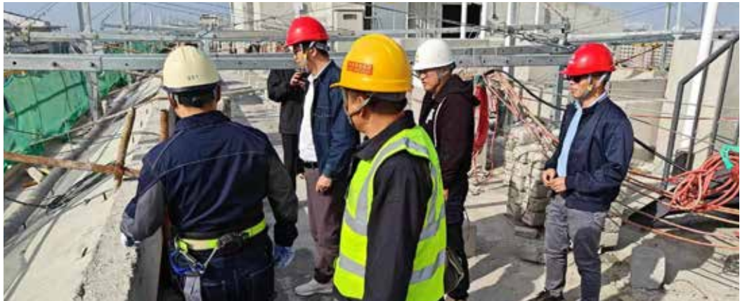
施工现场安全检查
